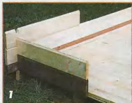
На выровненной площадке монтируют настил-пол, на котором начинают возводить стены постройки. Опорой для настила могут служить небольшие бетонные блоки.
