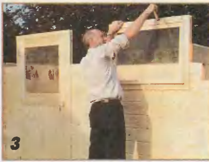
Дверной и оконные блоки имеют пазы, которыми они фиксируются в дощатых стенах.
