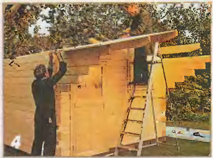
Для формирования свеса крыши над входом в домик верхние доски боковых стен «напускают» друг на друга.
