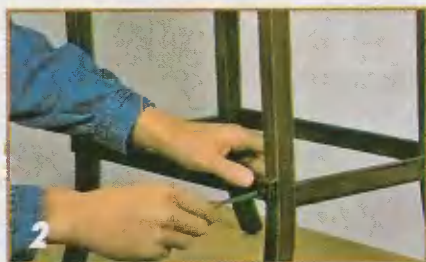
2 Крепят проножку с задней стороны столика.
